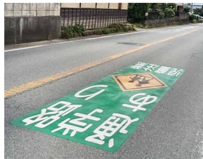
通学路の交通安全対策として市が設置した道路舗装
