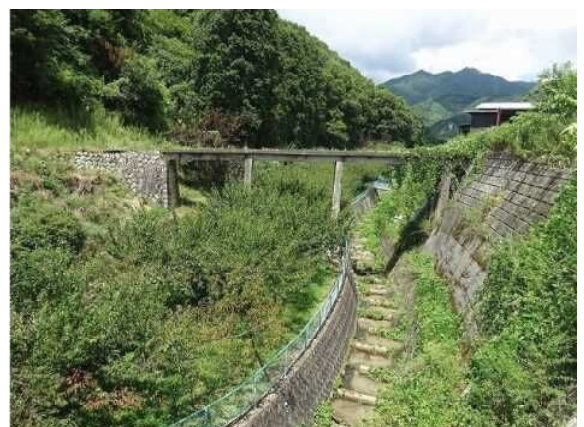
トロッコ軌道のコンクリート橋
